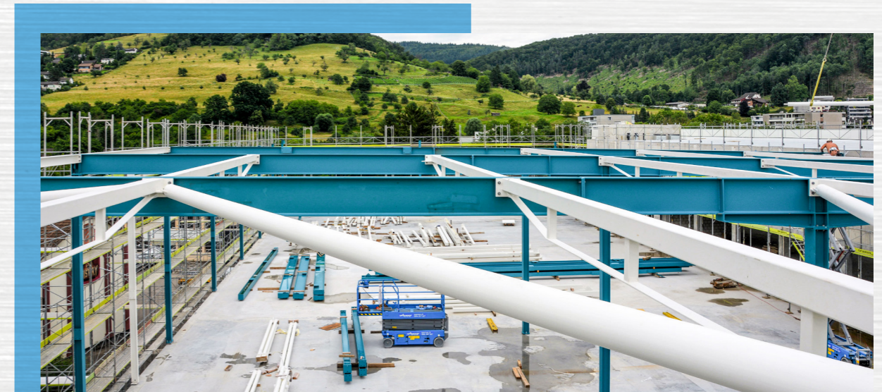
Neubau Tiba Liestal Gewerbebau / Industriefassade | Liestal | 2021 Generalbau
